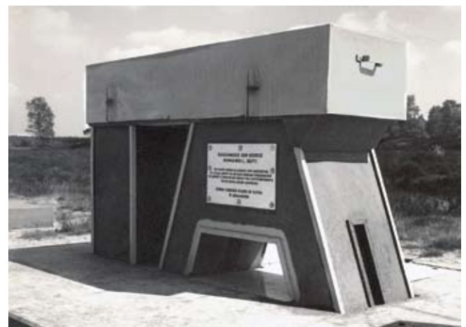
Fig. 8. De ijkbasis gereed: "... De totale lengte van de basis bedraagt 576,09225 meter ... tot op 0,05 millimeter nauwkeurig ... Streng verboden pijlers en sloten te beschadigen". (bron: NCG)
